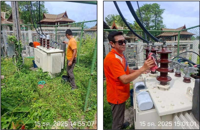
รูปภาพที่ 2.31 การตรวจสอบการทำงานของระบบไฟฟ้า
